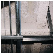
Flocage sur une poutre derrière un faux plafond
