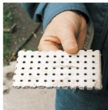
Tuiles de faux plafond
