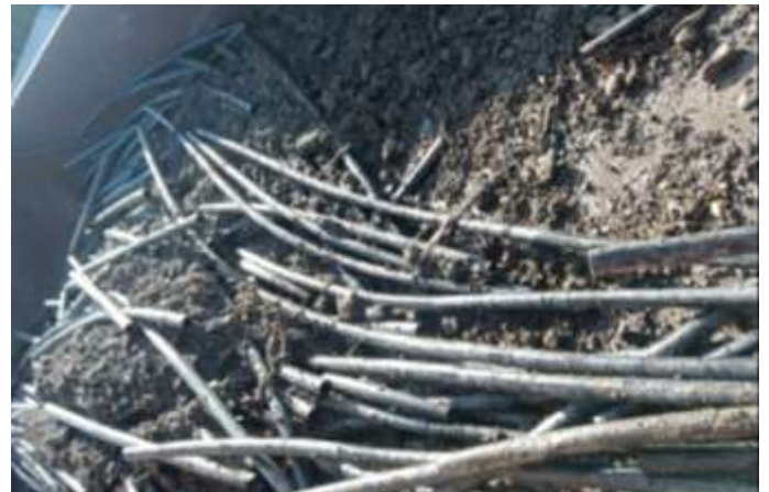
Chargement plein de terre/roche mélangé avec la tubulure
